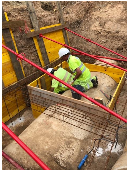
Ejecución de pozo
